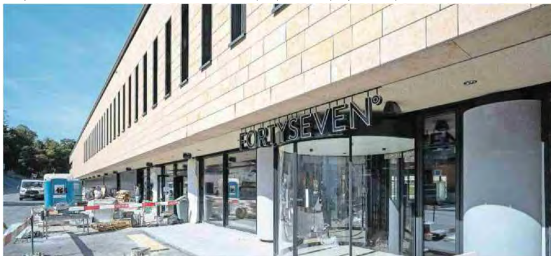
Die Eingangstüre der Wellness-Therme steht bereits.
