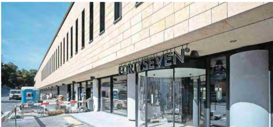
Die Eingangstüre der Wellness-Therme steht bereits.
